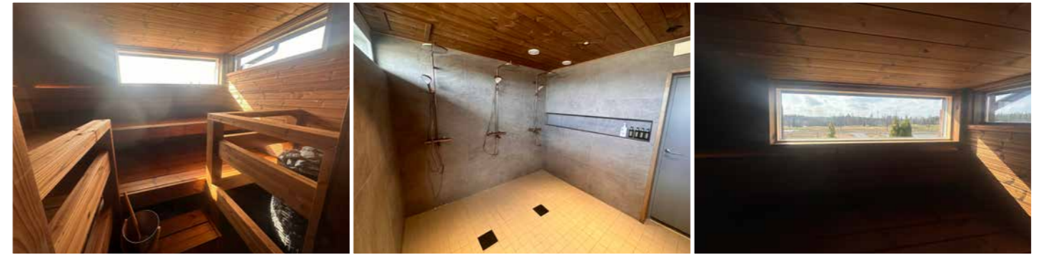
"Sauna ja pesuhuone on myös saaneet uudet pinnat talvenaikana. Lisäksi saunasta vaihdettiin rikkiäinen ikkuna uuteen ja isompaan ikkunaan, jolloin sieltä näkee jatkossa myös kentälle
